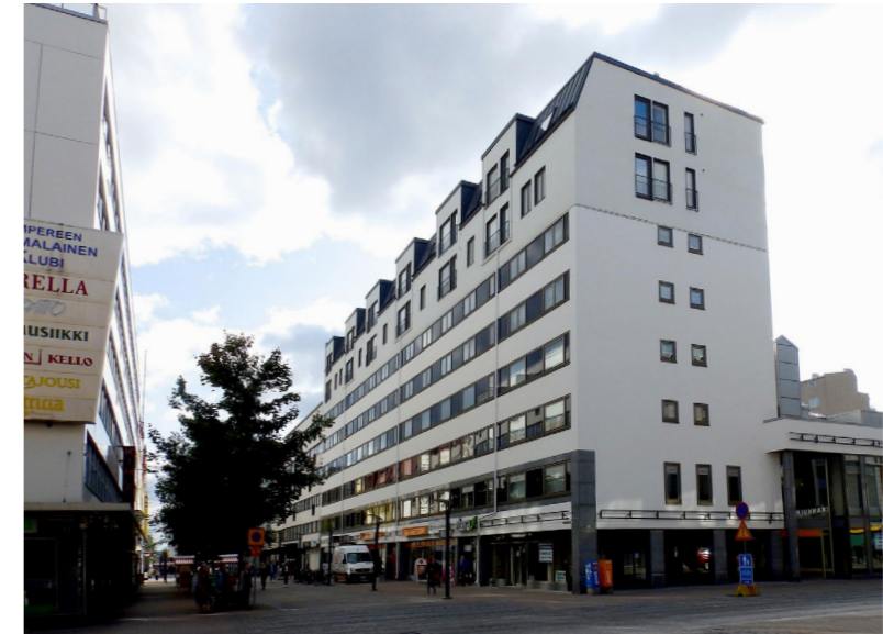
Vuonna 2017 valmistunut Kuninkaankatu 22 asuinrakennuksen korotus Tampereen keskustassa selvitysalueen tuntumassa. Kuva: Arkkitehtitoimisto Neva.
