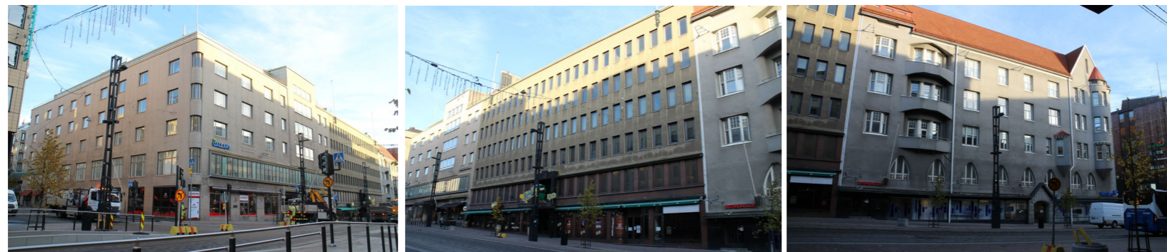
Tuotannon talo, Kansallispankin talo ja Yhdyspankin talo Hämeenkadulta. Rakennuskohtaiset ominaisuudet on sijoitettu luettelomaisesti selvityksen loppuun liitteeseen 2.
